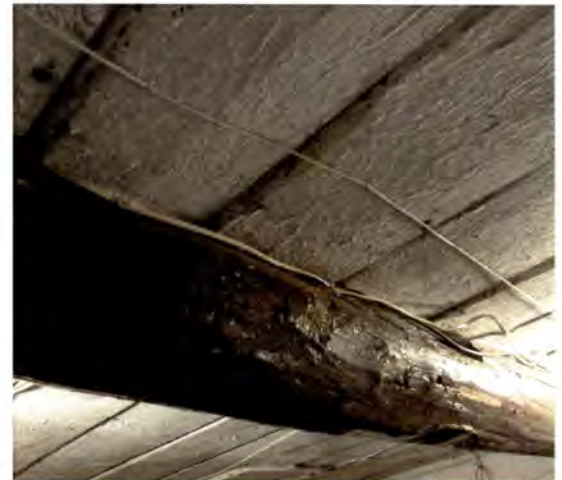
Poutre de soutènement du plancher du rez-de-chaussée.
