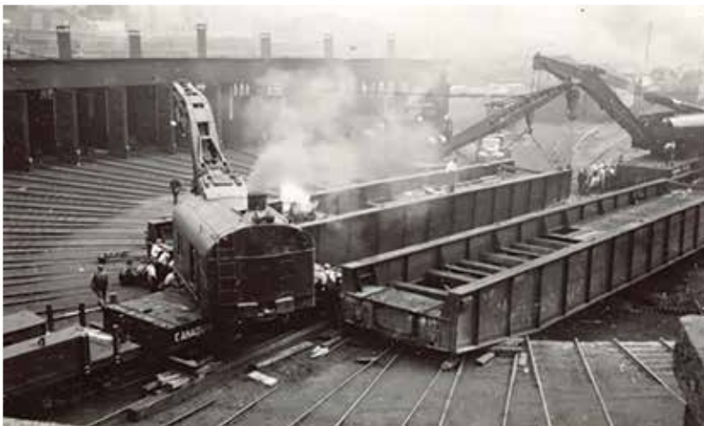
Photos prises par le mécanicien Hector H. Stanley MacD. Une vue vers l'est de Montréal, montre la gare de triage ainsi que la rotonde. Un gros plan de la table tournante illustre le transfert d'un wagon sur celle-ci et les stalles où les wagons sont conduits pour être réparés. En bas, à droite, Hector H. Stanley MacD et la liste des personnes figurant sur la photo couverture du présent numéro de Mémoire vivante.
